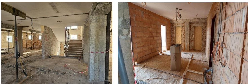
Fotografie 4: Střední škola polytechnická, Olomouc – Rekonstrukce domova mládeže
