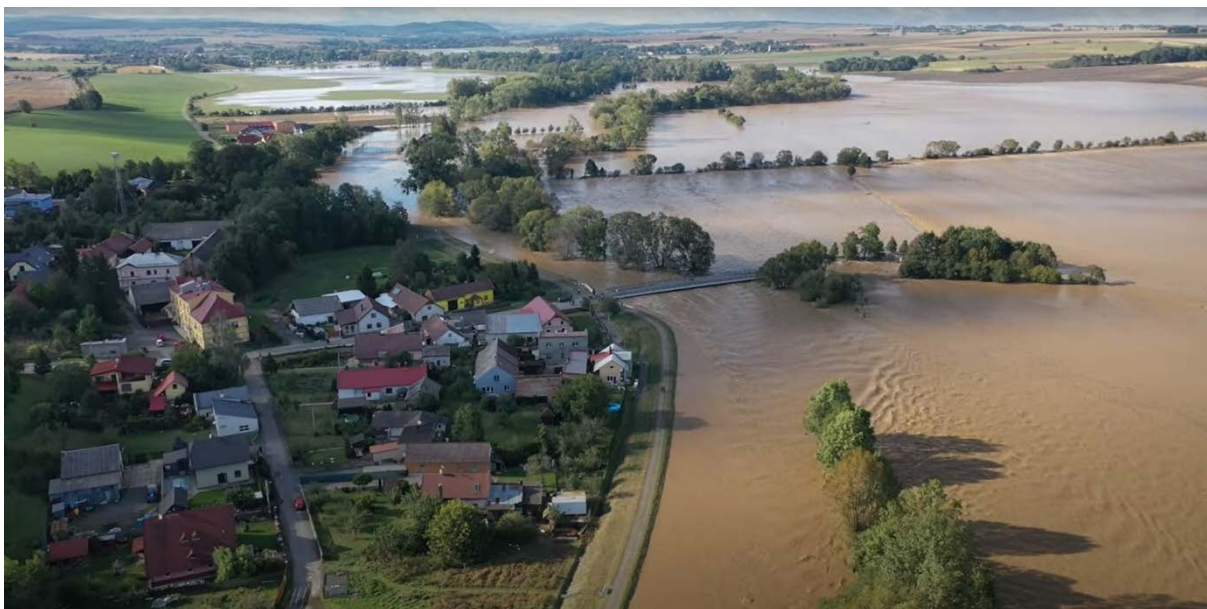
Obr. 5.2 PPO Holasovice na Opavě během povodně.
