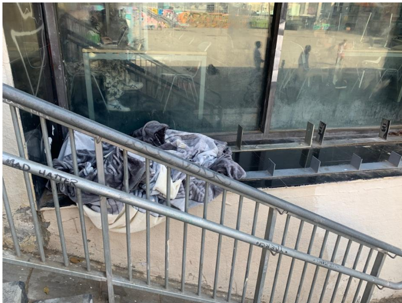
Obrázek 5 – pokrývky obalující úhelníky, které mají zamezit ležení na širokém parapetu okna. Patrně pozůstatek po nočním útočišti. Barcelona, El Raval. Zdroj: archiv autorky.
